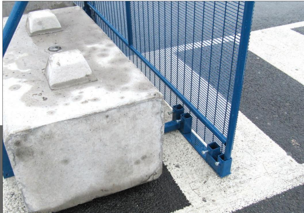
START/STOP BRACKET OFFSETS BALLAST FROM START/END OF RUN
